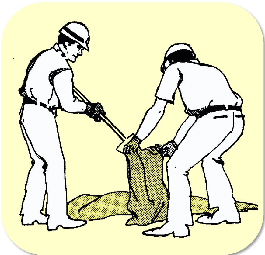
Riempimento dei sacchi di sabbia
